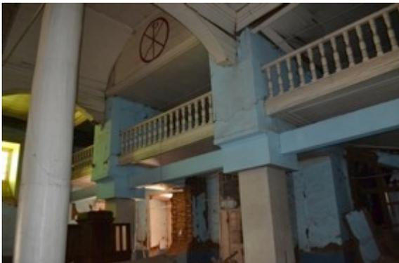
Interior Iglesia: coro y sotocoro, hacia sector de acceso (se aprecian pilares de hormigón armado y estructura de adobe).
