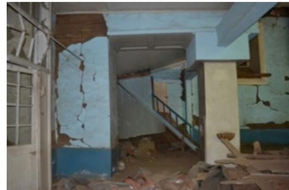
Interior Iglesia: sector de acceso central, sotocoro (se aprecian pilares de hormigón armado y estructura de adobe).
